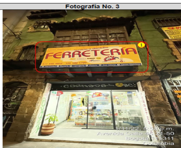
Elemento de publicidad tipo aviso en fachada, el cual no se encuentra ubicado en fachada propia (donde el establecimiento de comercio ejerce su actividad económica), y no cuenta con registro de publicidad exterior visual de la SDA.
